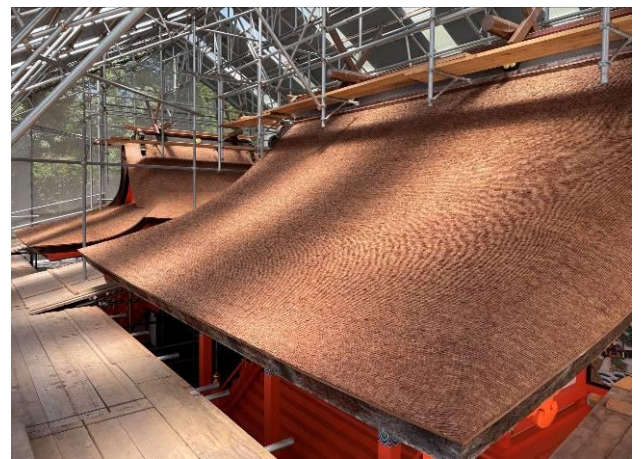
■葺き替えが完了した本殿2社の檜皮葺屋根
