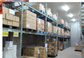
作業風景と低温倉庫
