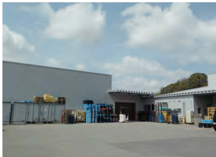
和歌山センター全景
