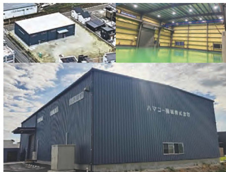
会社外観・工場内
