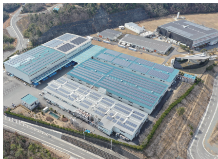
和歌山工場全景
