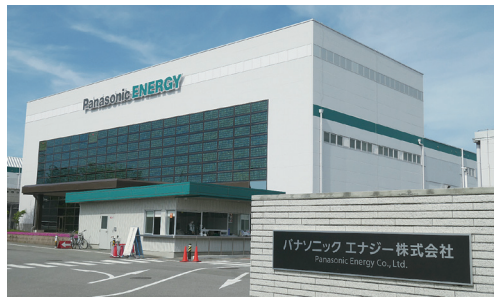
和歌山工場外観
