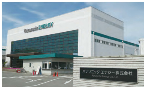
和歌山工場外観
