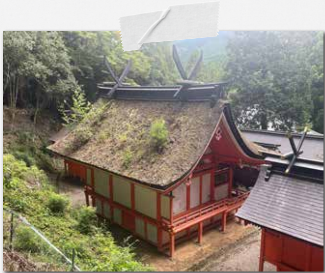
▲本殿屋根の現状
