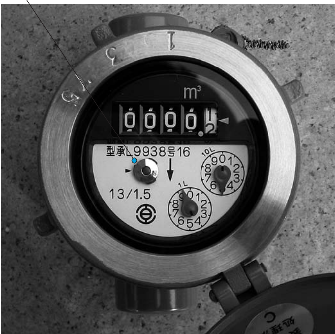
●水道メーターパイロットで、簡単に漏水点検
