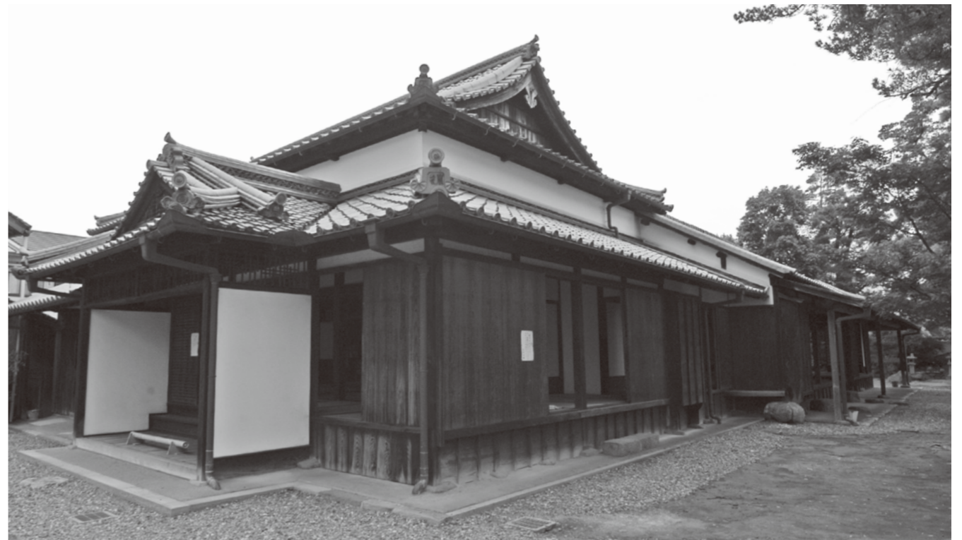
妹背家住宅の主屋は保存状態がよく、建築年代も明らかで、大和街道における本陣の遺構として高い価値があります。現在の主屋は、昭和44年に国の重要文化財の指定を受けた後、大規模な復元改修工事がなされ、往時の風格を醸し出しています。
