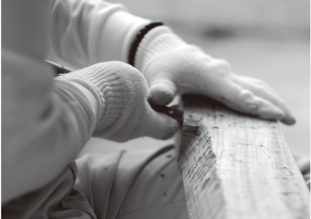
「地味な仕事」と三塚孝さんが言うように、文化財の補修は、根気のいる作業が続きます。今行っているのは、千手堂に設置する手すりの土台作り。礎石にびったり添わせるために、石の形に合わせて削ります。何度も何度も「具合を確かめては削る」を繰り返します。
