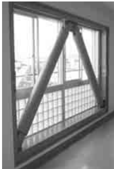
耐震補強された田中小学校
