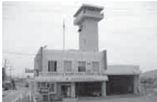
老朽化した南消防署
