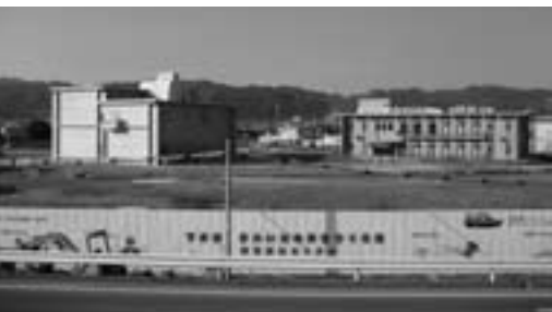
那賀浄化センター
