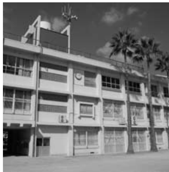
耐震工事が終了した田中小学校
