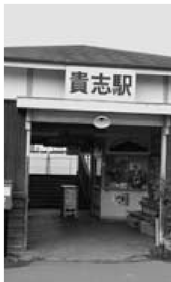
和歌山電鐵貴志駅
