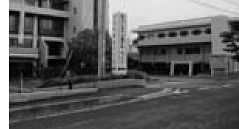
建設で撤去される現庁舎
