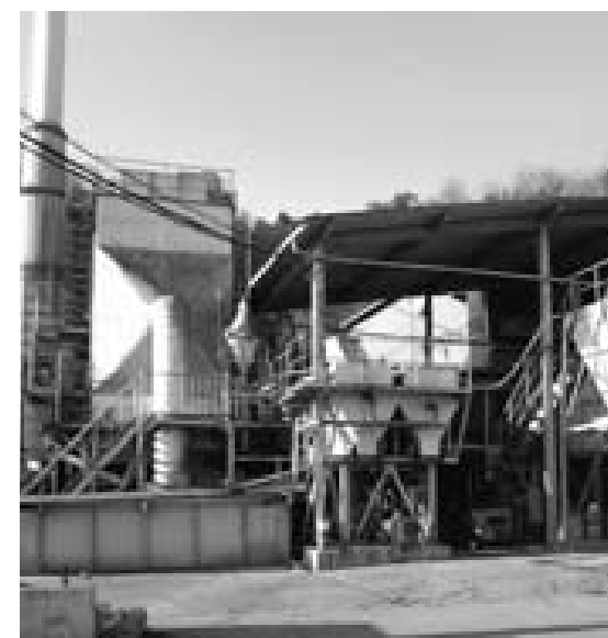
老朽化した打田美化センター
