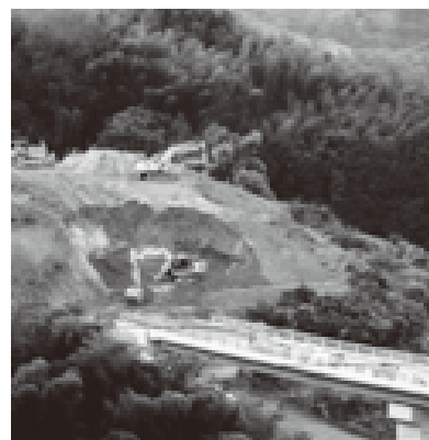
工事中の紀の里広域農道
