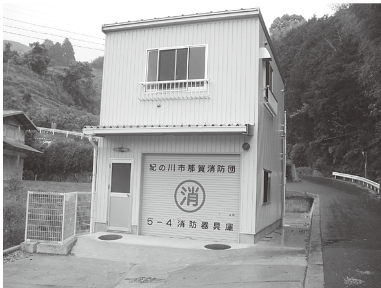
平成21年度に完成した消防器具庫 (地下に防火水槽を併設)
