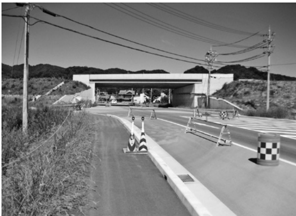
建設が進む京奈和自動車道
