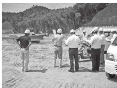
広域ごみ処理施設建設現場を視察
