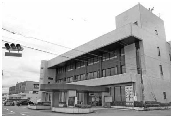
再利用される旧貴志川分庁舎
