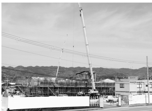
粉河地域に建設中の市営住宅
