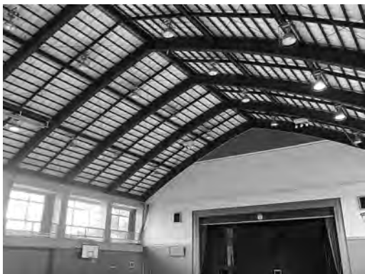
中貴志小学校屋内運動場
