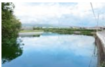
現在も残る呂の池（絵図中の③道池）
