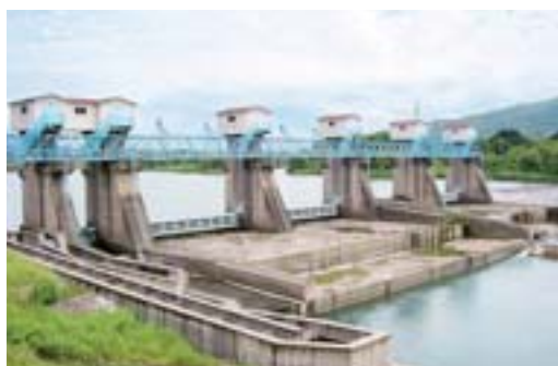
小田頭首工（橋本市高野口町）
