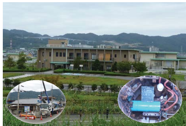
那賀浄化センター
