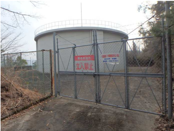
【貴志川第1配水池】
