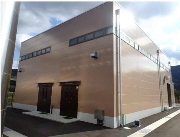
【穴伏浄水場 膜ろ過棟】
