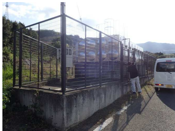
【麻生津東部配水池】
