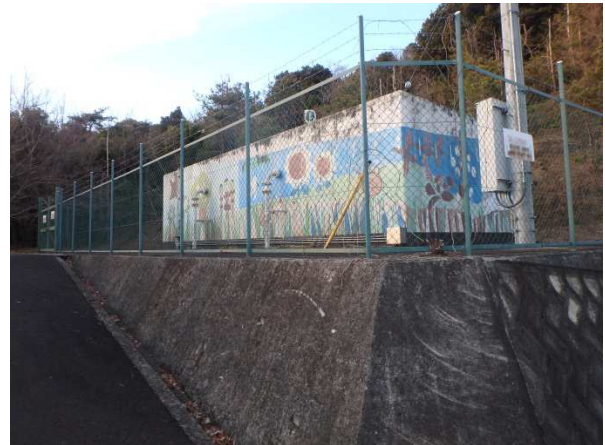
【打田 高野配水池】
