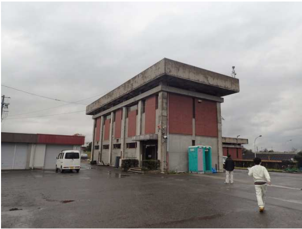
【花野浄水場 管理棟】
