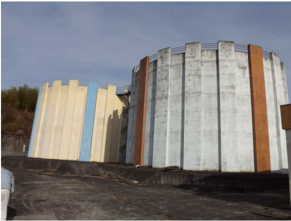
【打田第1配水池】
