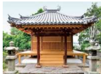
藤崎弁天堂の保存修理
