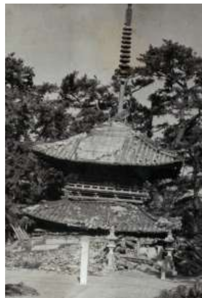
台風で倒壊した長田観音三重塔 (昭和36年(1961年)9月)
