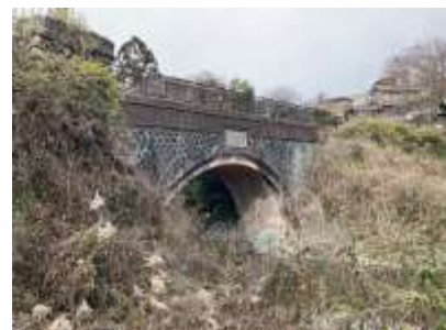
小田井用水路 龍之渡井
