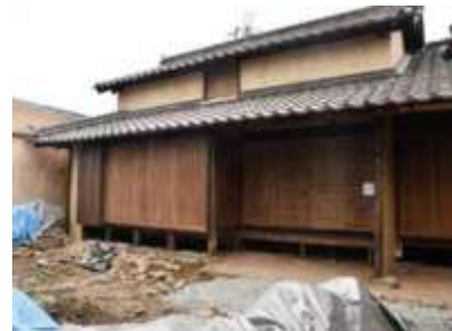
名手役所主屋の保存修理
