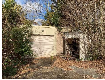
防災倉庫の状況
