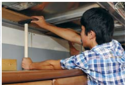
（写真左）直径40mmのホースを使用した放水訓練。 （写真中）地震に備え、転倒防止ポールでタンスを固定する。L型金具を用い、木（もく）ねじて壁と家具の天板の固定を行う練習も行った。 （写真右）那賀消防組合の司令室を見学。
