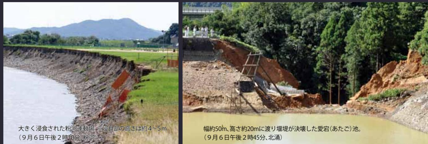
大きく浸食された粉河運動場 ※浸食部の高さは約4~5m（9月6日午後2時10分、粉河）
