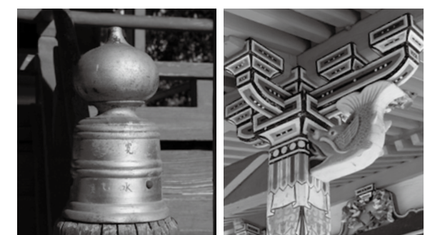
勾欄擬宝珠(八幡神社本殿) 向拝木鼻の鮫(羊の宮本殿)
