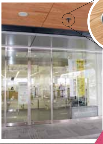
▲建物側の送受信装置
