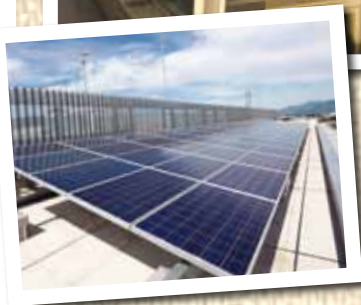
▲エコボイド頂部の太陽光収集装置 ◀屋上に設置された太陽光発電装置
