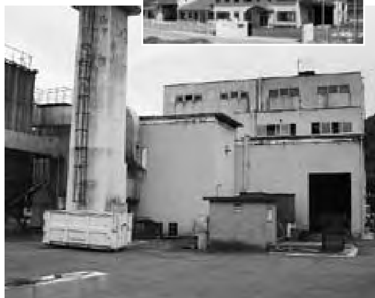
解体する貴桃クリーンセンター
