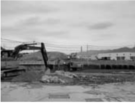
京奈和自動車道建設現場
