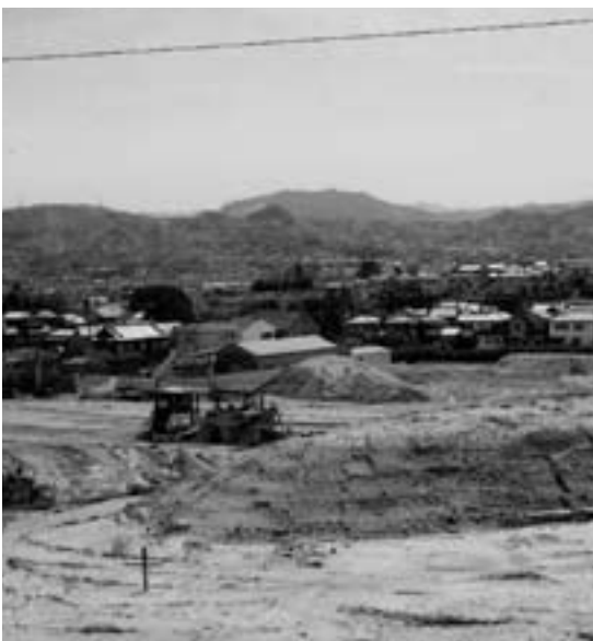
ほ場整備工事（北山地区）
