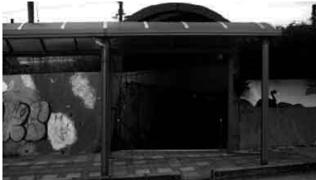
粉河駅南側地下道入口
