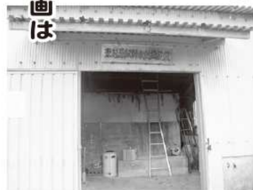
地元が運営する飲料水供給施設
