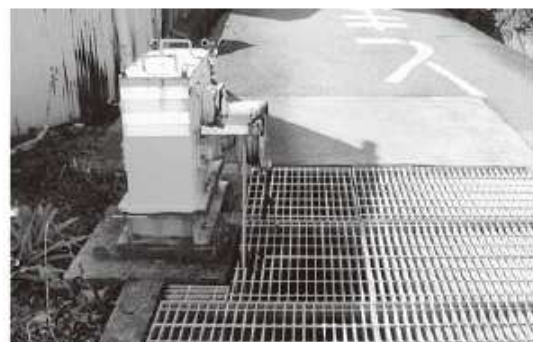
道路上の樋門閉鎖装置 (貴志川町)
