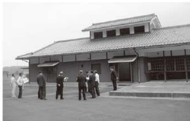
農業集落排水処理施設
