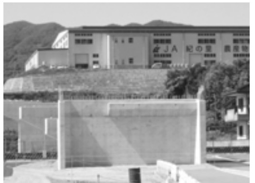
建設中の井田中ノ才線
