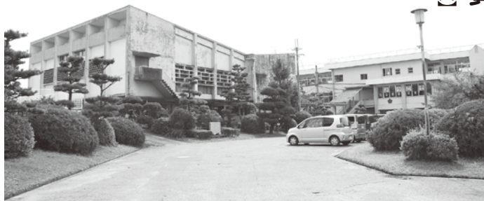
取り壊される池田小学校講堂
