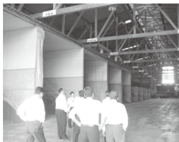
●山鹿市バイオマスセンター
