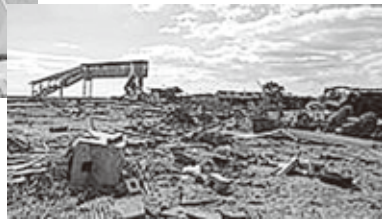
福島県相馬 新池駅 (津波により駅舎が全壊)
