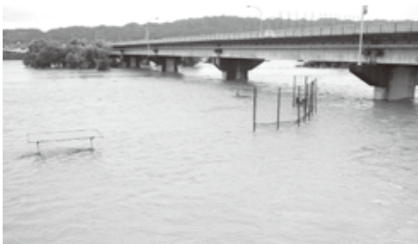
浸水した桃山グラウンド
