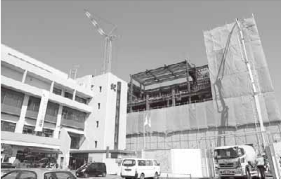
建設が進む新庁舎
