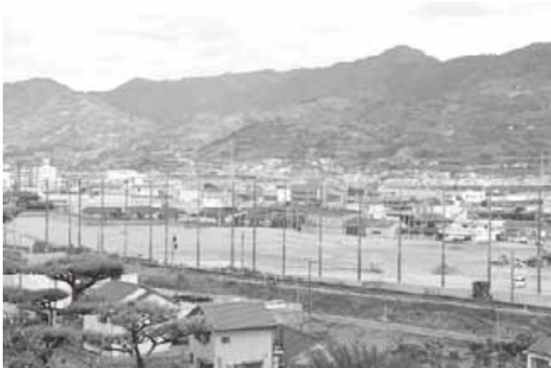
着工された粉河中学校
