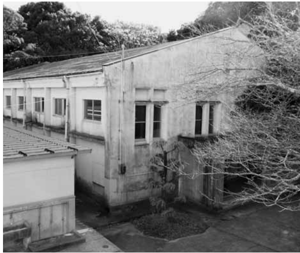
老朽化の著しい旧体育館（那賀中学校）
