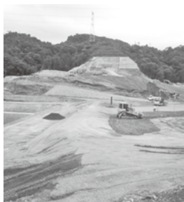
紀の海ごみ処理施設の造成工事
