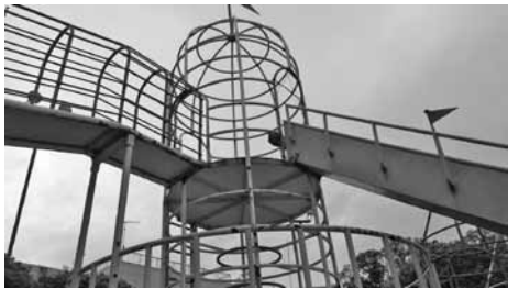
さびて危険な遊具
