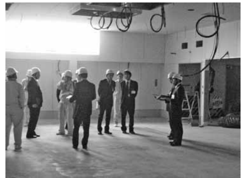
河南学校給食センター建設現場を視察
