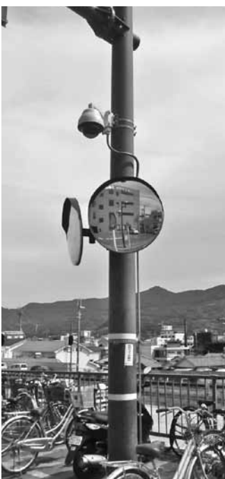
設置された防犯カメラ
