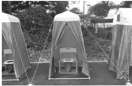
マンホールトイレ
