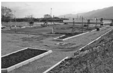
建設中の芝生広場
