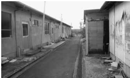
市営調月宮ノ前住宅
