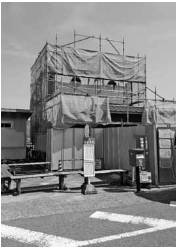
建設中の観光交流施設
