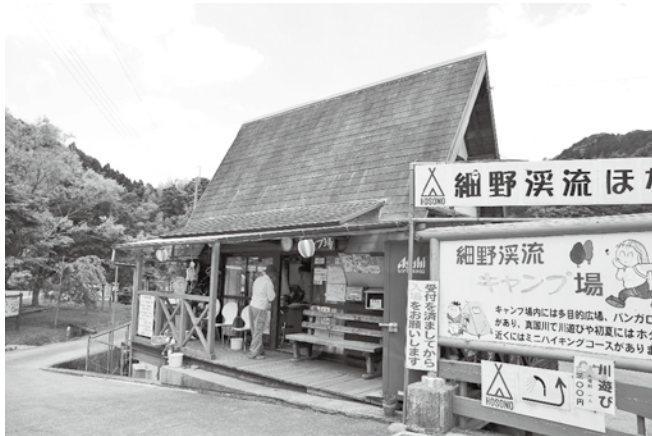
建て替え予定の管理棟
