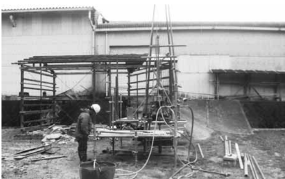
現場の地質調査
