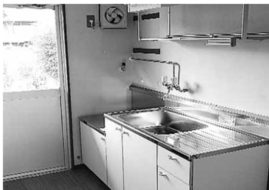
きれいに修繕された内装
