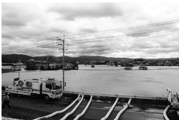
平成29年度 冠水した丸栖地区
