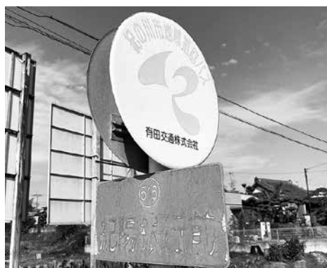
劣化したバス停標識
