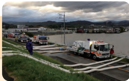
ポンプ車での排水作業
