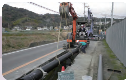
耐震管布設工事
