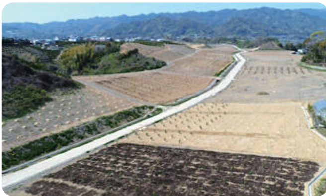
▲ ほ場整備(下丹生谷地区)
